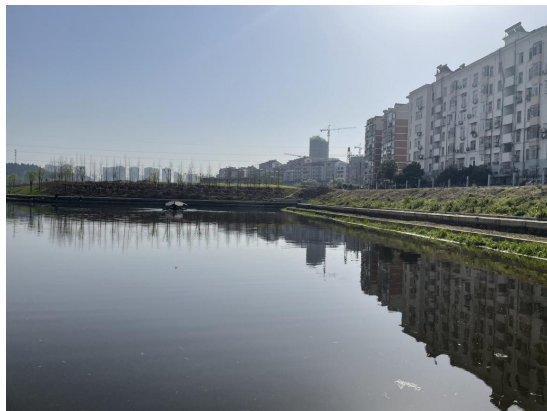
驳岸土地平整、护坡
