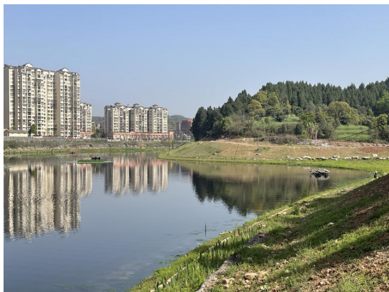
驳岸土地平整、护坡
