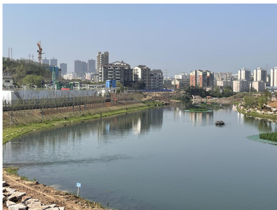
驳岸土地平整、护坡
